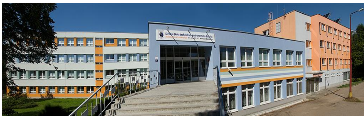
Panoramatický pohled na školu z Bezručovy ulice s původním vstupním schodištěm
